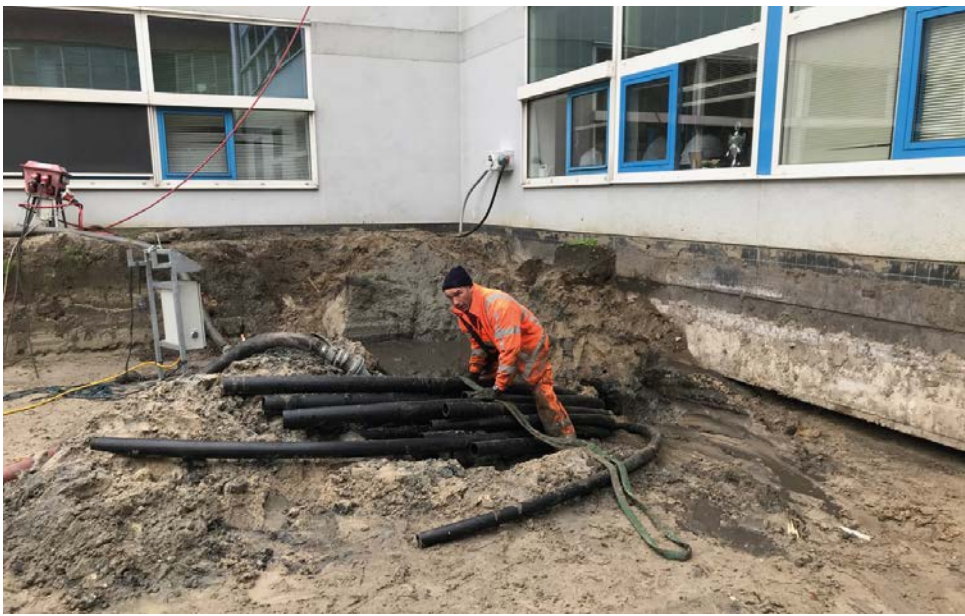
Voor de voeding van het nieuwe OK-complex werden door middel van een geboorde sturing kabels onder het ziekenhuis door getrokken (foto: Breedveld & Schröder).
